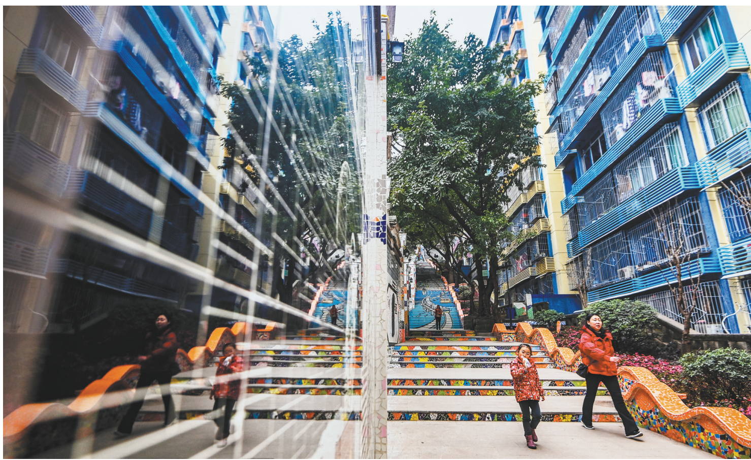
《“时光里”步道旁的楼栋外墙焕然一新,之前的老旧雨棚已被拆除。》
