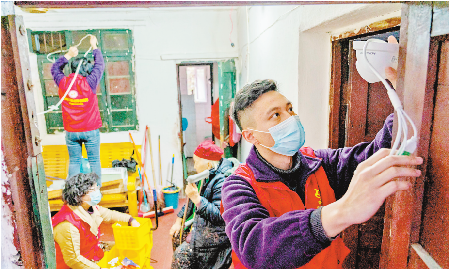
2月2日，沙坪坝区磁器口街道凤凰村，街道养老服务中心的工作人员在独居老人周素珍家里安装智能照护设备。
