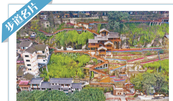
作为环城步道戴家巷支线的一部分,戴家巷崖壁步道位于渝中区嘉陵江畔,往下延伸至嘉陵江边,往上抵达戴家巷老街区。步道长约750米,其中高空步道300米,高差接近60米。
