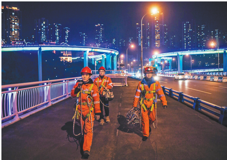
▲1月11日,菜园坝大桥,工人们携带着灯饰维修装备准备上桥。
