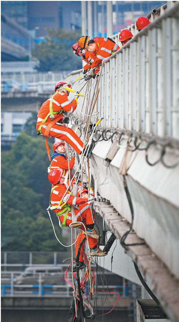
▲1月11日,鹅公岩大桥,工人们悬挂在桥的一侧作业。
