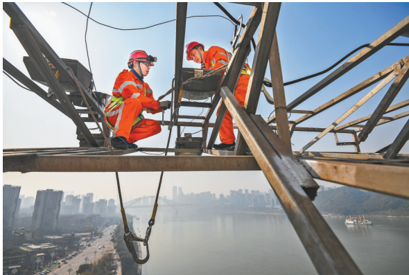
▲1月13日,大佛寺长江大桥,工人们正在灯架上作业。
