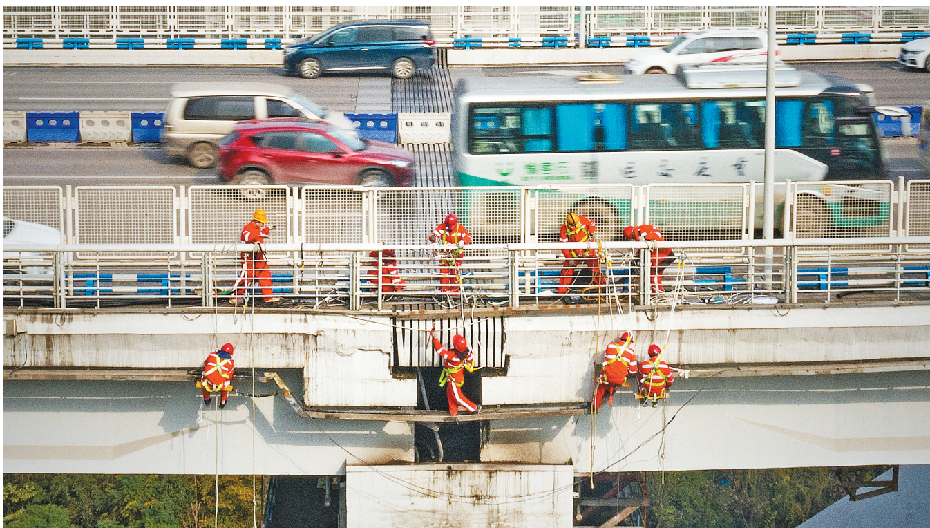
◀一月十一日,鹅公岩大桥,灯饰工人们配合默契地更换大桥灯饰主电缆。
