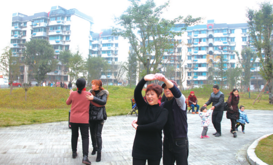
改造后的老旧小区
