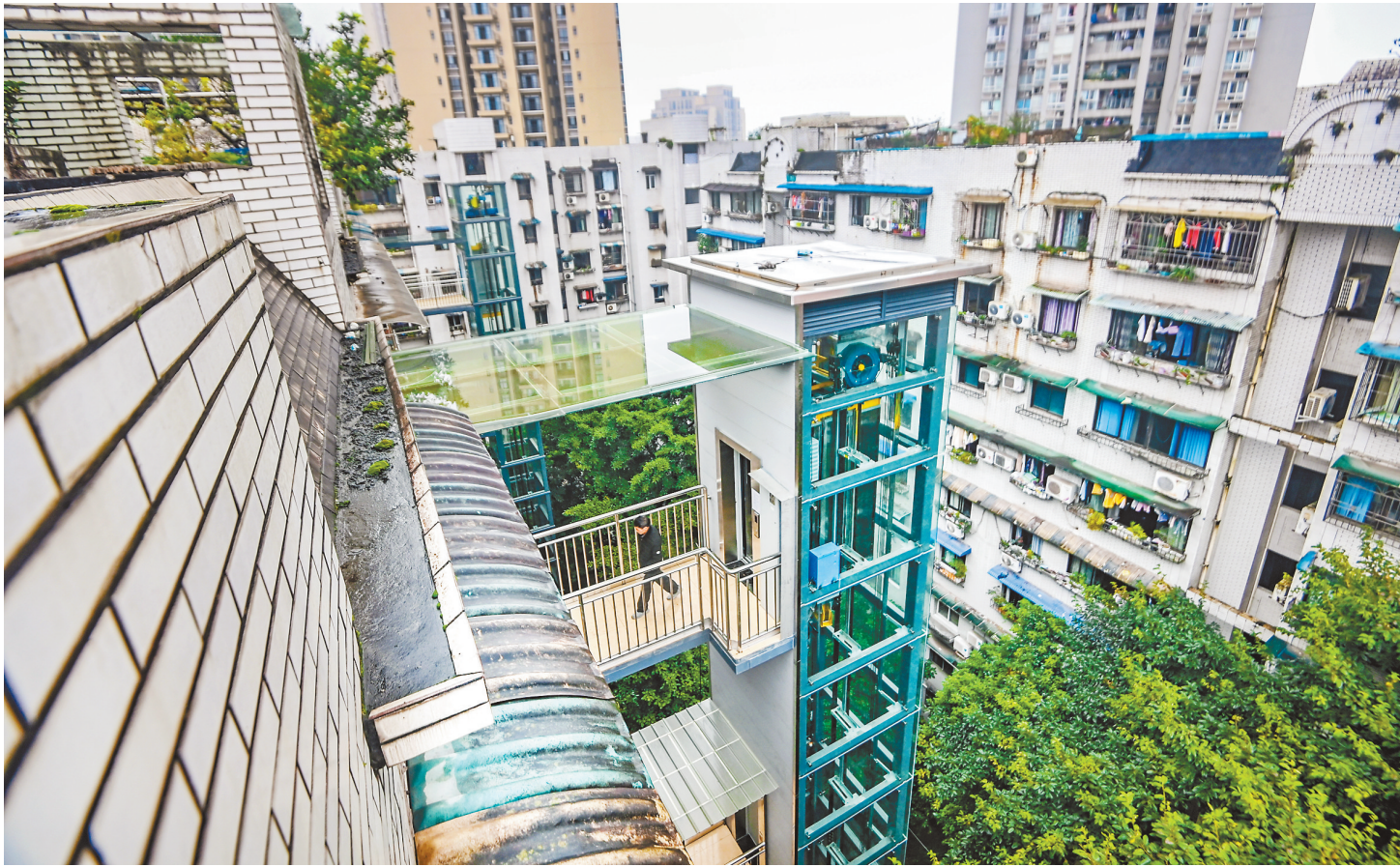
二〇二〇年十一月一日,渝中区大坪街道,竞地城市花园二一单元楼加装的电梯已投入使用(本报资料图片) 记者 龙帆 摄/视觉重庆
