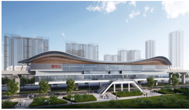
市域快线璧铜线铜梁站
