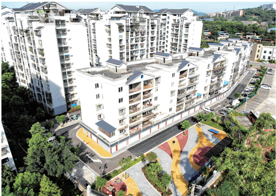
永川漂布坊老旧小区整治
