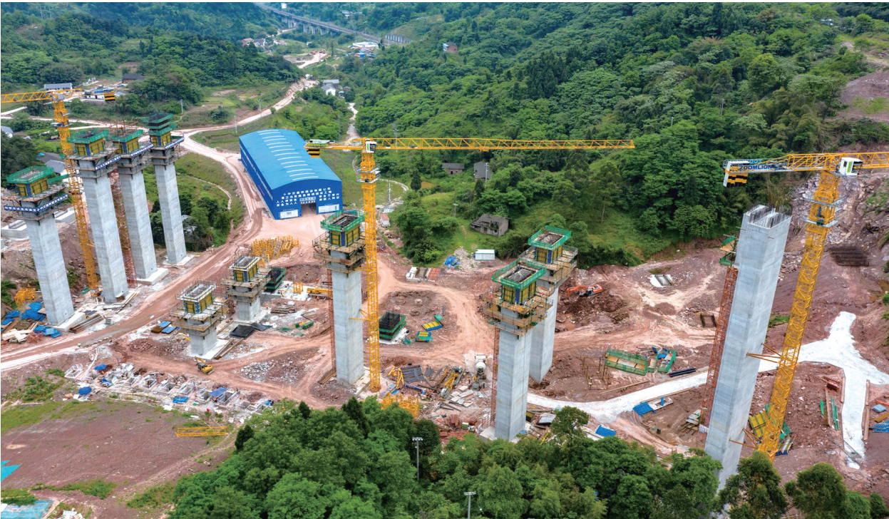
国有资本服务交通基础设施建设。图为綦江北互通连接线建设工程施工现场
