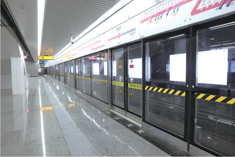
六号线支线二期清溪河站站台门
