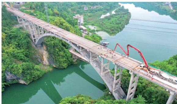
抢建“扶贫桥”，贯通致富路。宫河大桥于2020年7月初顺利竣工通车。
