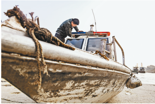
◀ 12月21日，江津区油溪镇油溪码头，工人正在拆除编号“渔巡001”的巡护艇。 记者 龙帆 摄/视觉重庆
