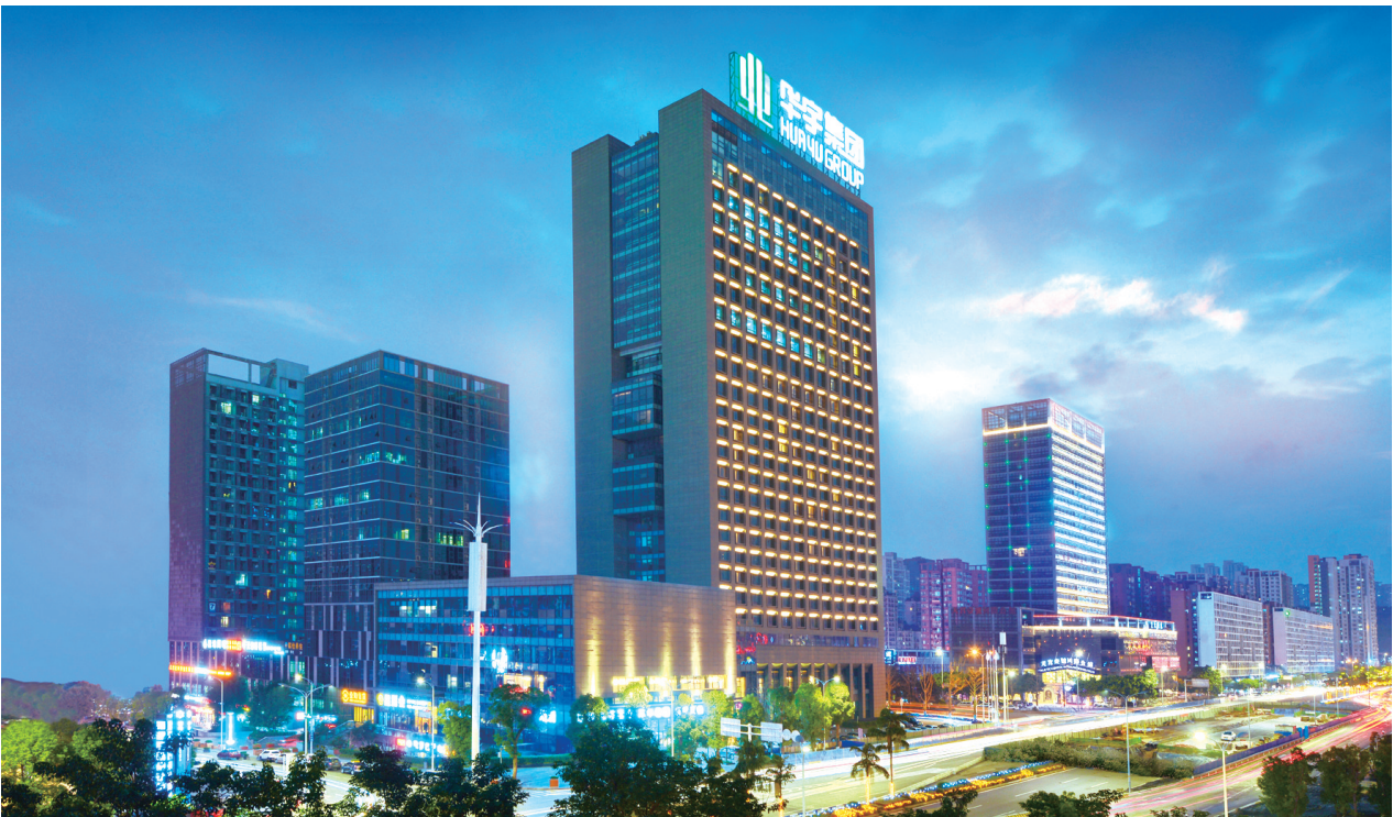
重庆华宇集团总部大楼
