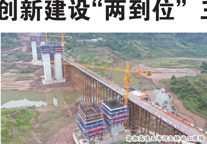
渝湘高速五布河尖桥施工现场
