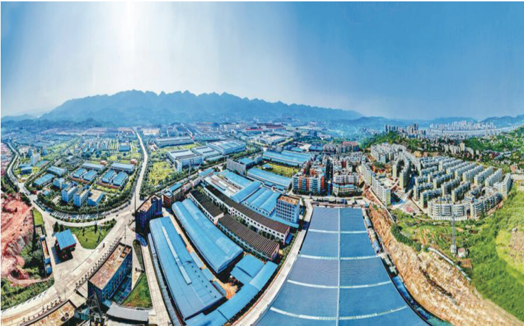
国家新型工业化装备制造、食品(粮油加工)产业示范基地——江津德感工业园
