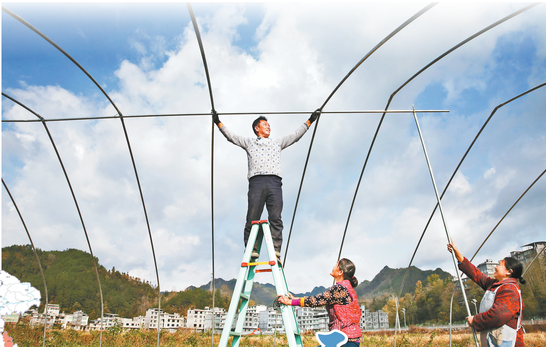
十一月十八日，黔江区鹅池镇鹅池社区，村民在搭建温室大棚发展产业。特约摄影 杨敏 视觉重庆
