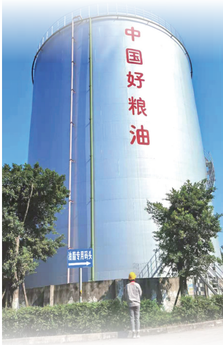
“中国好粮油”储油罐
