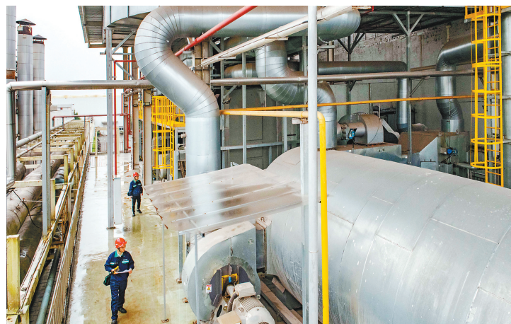
2020年10月28日,在位于两江新区的长安福特二工厂,涂装车间设备维护人员正在对挥发性有机物(VOC)处理系统进行巡查。
