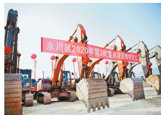
永川区2020年第三批重点项目集中开工 摄/袁卿予
