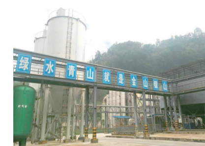
武陵锰业渗滤液收集处理设施
