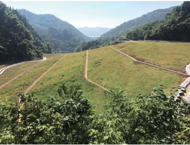
整治后的鑫发电解锰渣场
