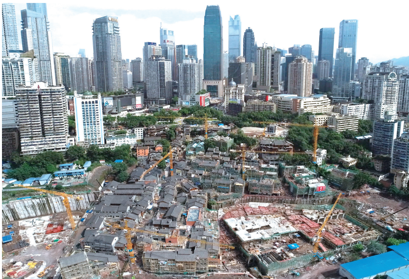
正在施工中的十八梯传统风貌区
