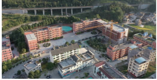
沙坝乡中心学校的中信科普楼在修建中
