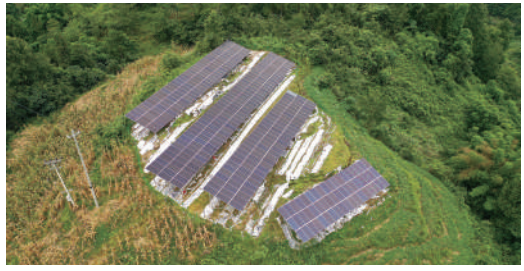
为木良村建设渝东南片区首座村级光伏发电站
