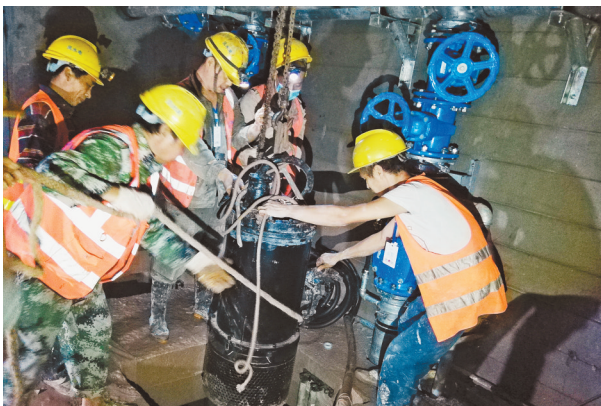
6号线支线二期刘家院子站施工现场,工人正在安装潜污泵。(机电工程公司六支二项目部供图)
