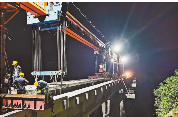
铁路东环线野竹沟双线特大桥桥梁架设现场。(梁成供图)
