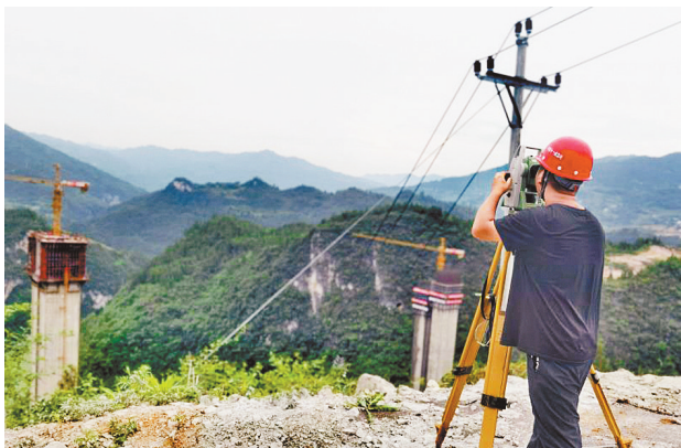
城开高速测量人员正在进行大桥标高复测。(李灿供图)
