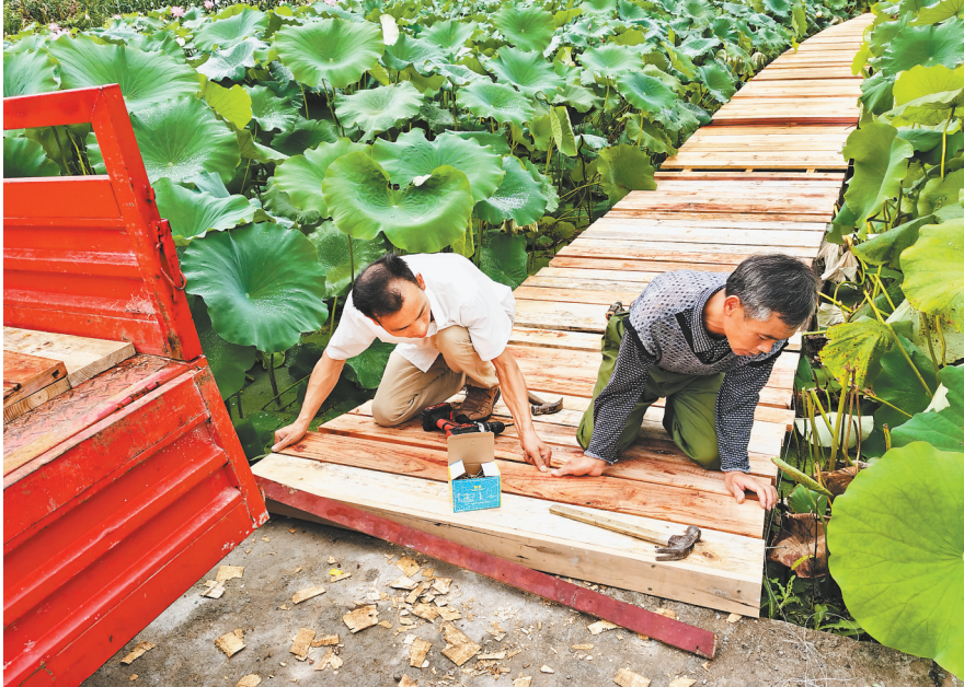
冉渊腾（左）在铺装栈道。
