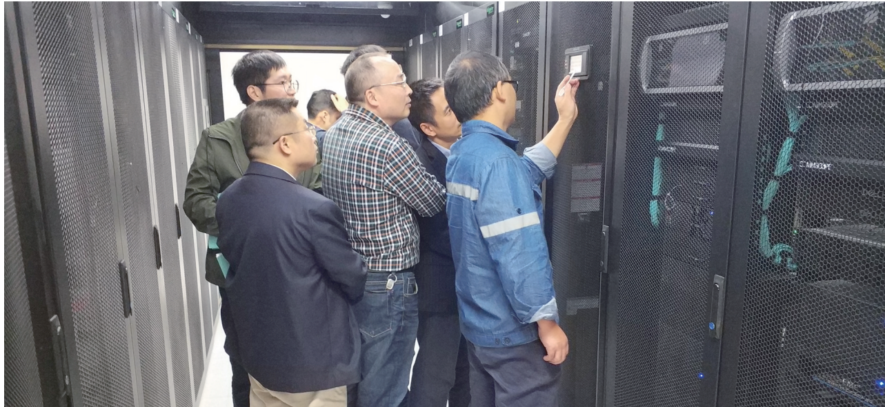
信息中心员工和施工人员对设备进行调试
