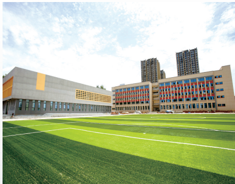
2020年秋季城西中学改扩建工程竣工投用
