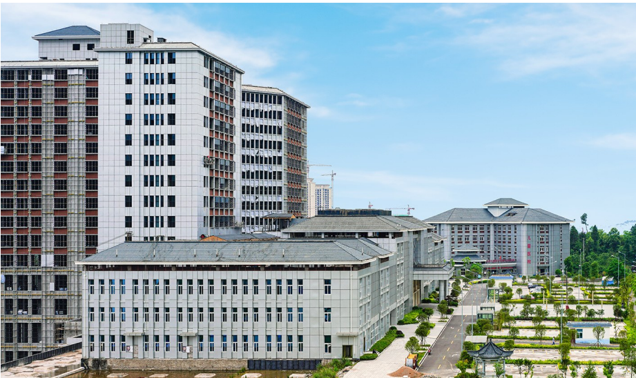
建设中的黔江中心医院新院区
