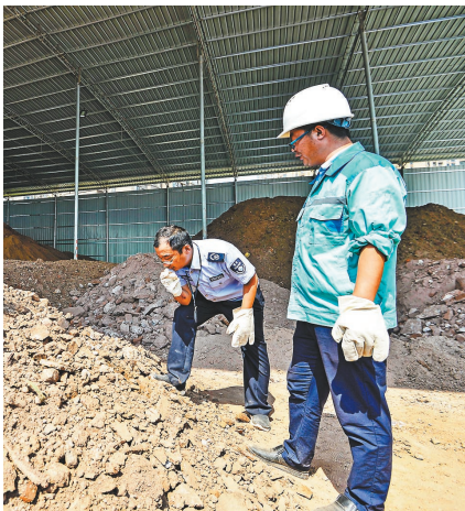
8月28日,沙坪坝区,中国嘉陵工业股份有限公司(集团)原址局部场地污染土壤治理修复工程现场,环保执法人员正在现场开展执法检查。
