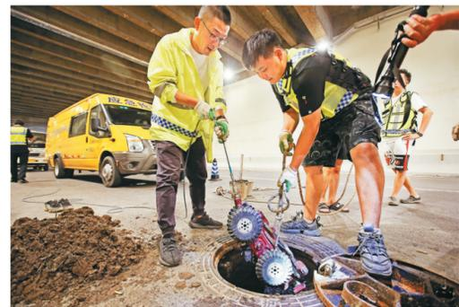
8月26日，在江北城下穿道，工作人员在机器人的帮助下精准定位堵塞点。 记者 罗斌 摄/视觉重庆
