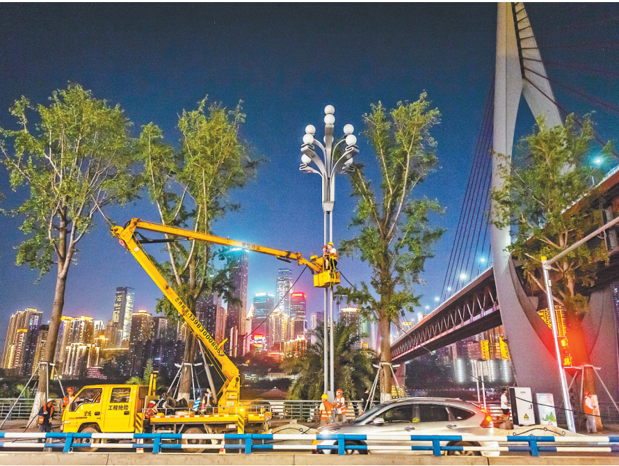
8月26日，南岸区南滨路，工人正在加紧搭建临时地面路灯电路主线，让路灯尽快恢复使用。 记者 龙帆 摄/视觉重庆
