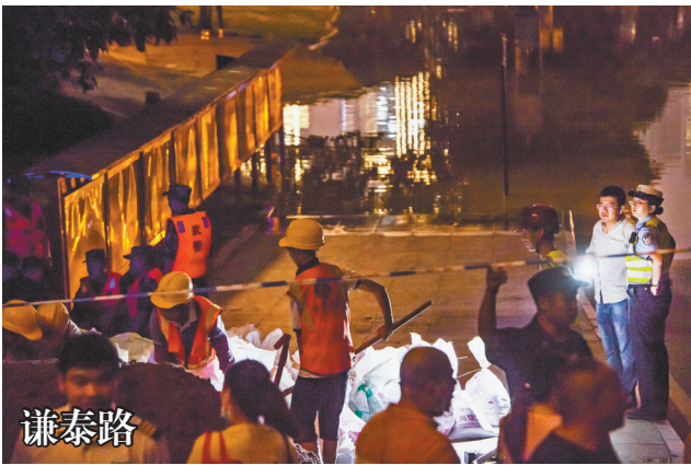
▲8月19日,南岸区谦泰路,洪水不断上涨,工作人员正在准备沙袋。 记者 龙帆 实习生 孙泊远 摄/视觉重庆
