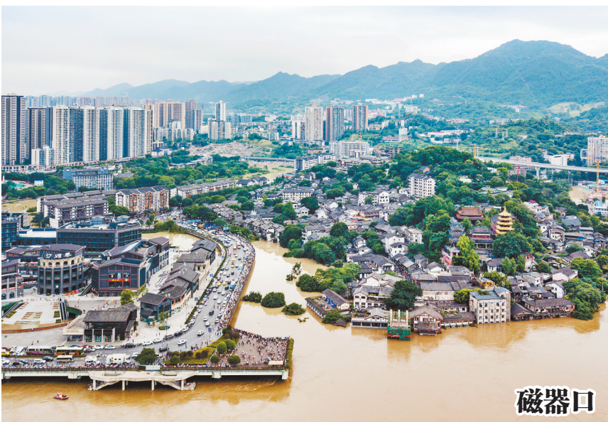
8月18日下午4点12分，磁器口古镇临江区域被洪水淹没。 记者 齐岚森 摄/视觉重庆
