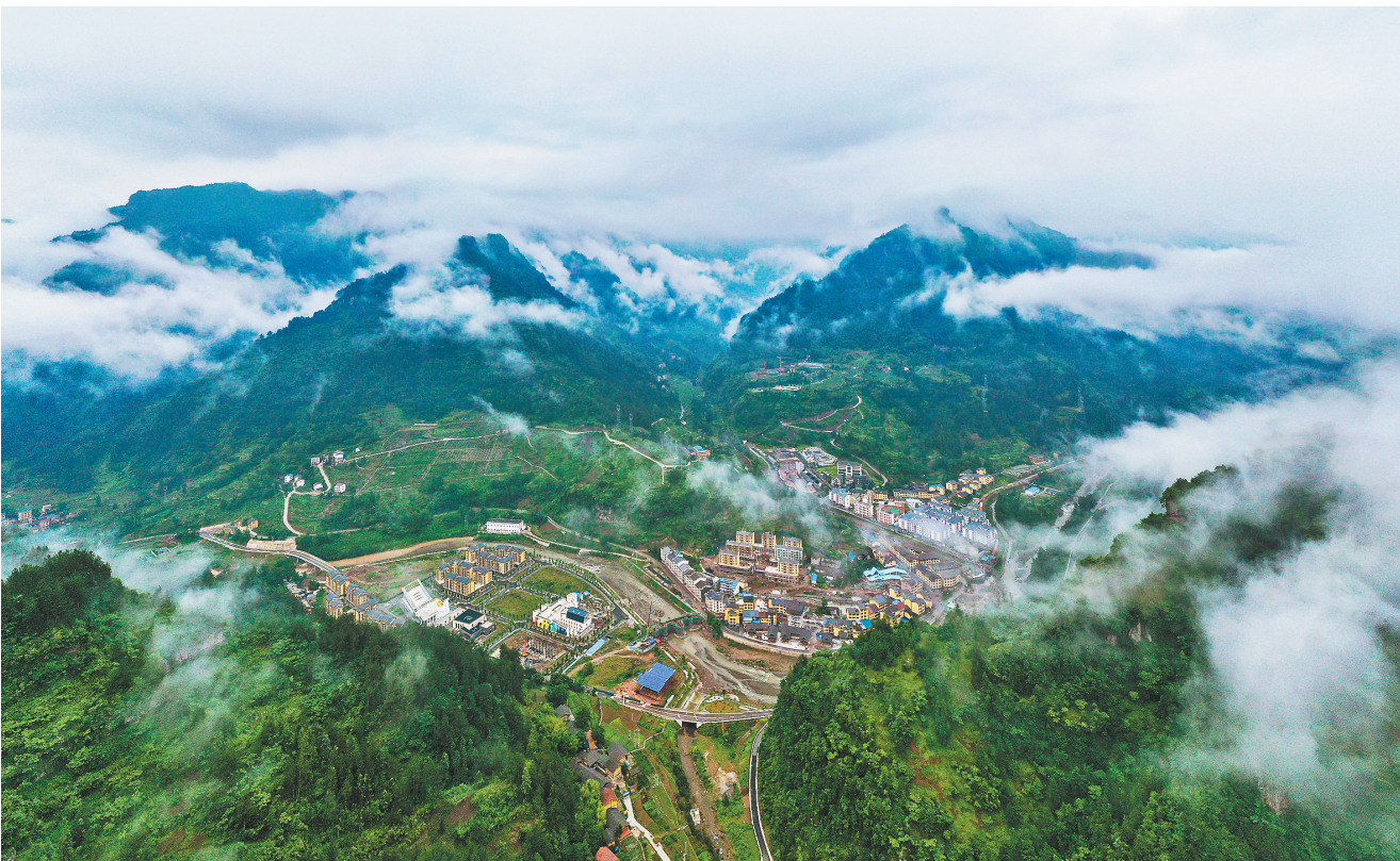
▲群山环抱下的石柱县中益乡场镇正有序建设。
