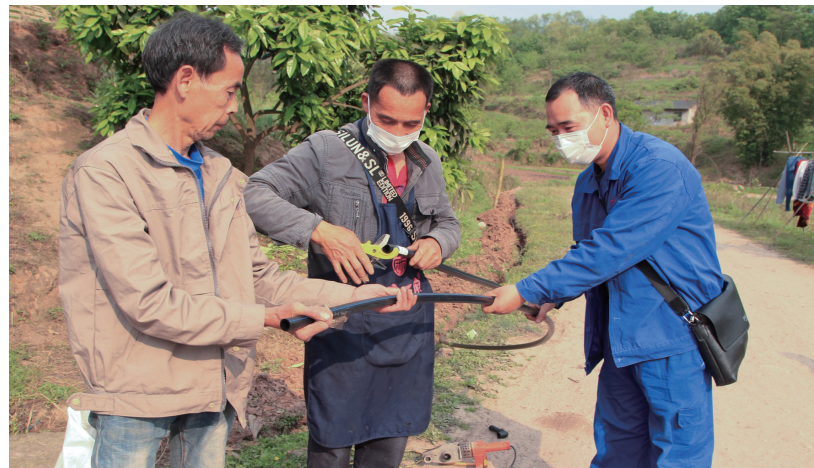
自来水安装现场
