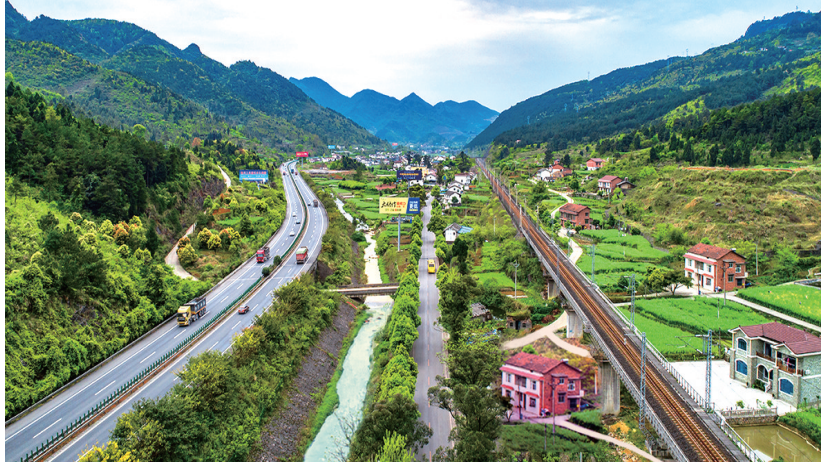
南涪铁路、渝湘高速、G353在水江境内同向延伸 摄/赵志
