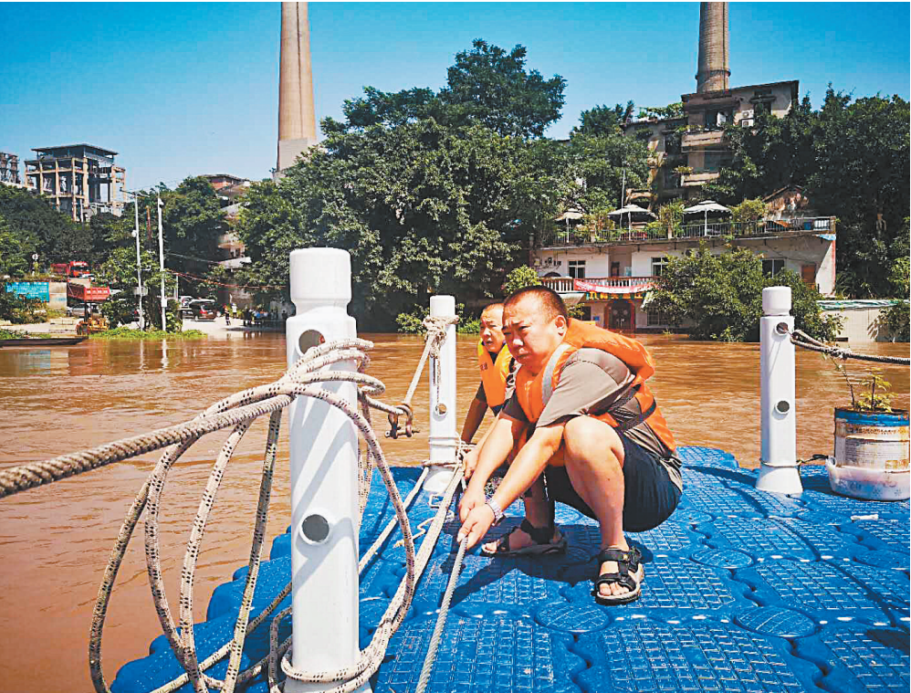
▲7月27日，九龙坡—李家沱车渡码头水位达到185米，重庆市车渡管理站的工作人员坚守一线，用绳索和钢缆对浮桥进行加固，保障救援物资和食品的正常补给，并针对江上突发事件提供24小时救援保障。 通讯员 李颖 摄/视觉重庆
