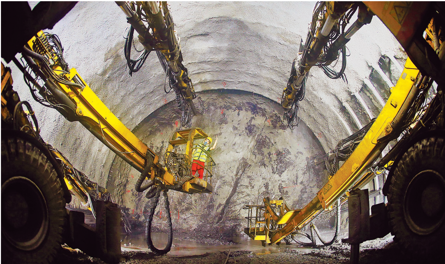
▲城开高速控制性工程吴家梁隧道,三臂凿岩台车正安全高效施工。
