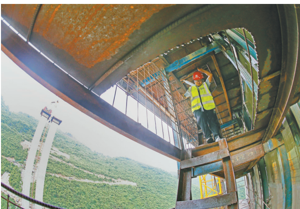
▲城开高速东河1号特大桥施工现场,建设者正在140多米高的桥墩上施工。
