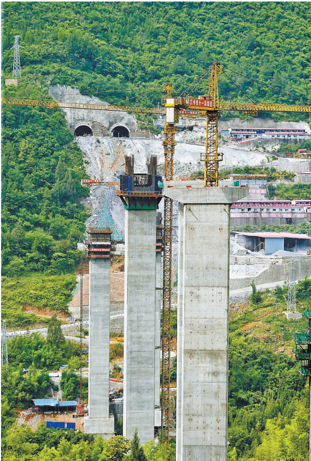
▲城开高速双河口特大桥下部结构施工即将完成。
