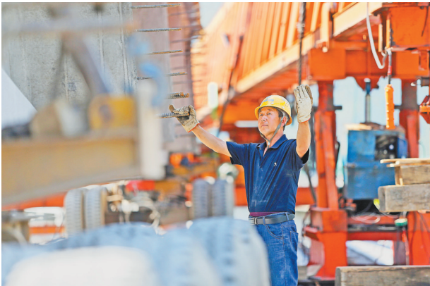
▲负责建设的中交一公局五公司建设者正在城开高速温泉特大桥紧张施工。
