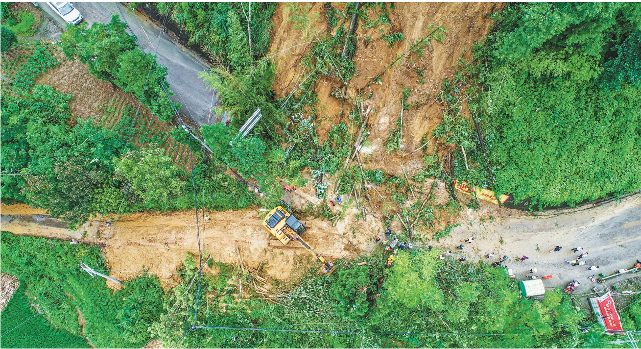
七月八日，暴雨导致酉阳南腰界镇山体滑坡，阻断交通，抢险人员正在疏通交通。
