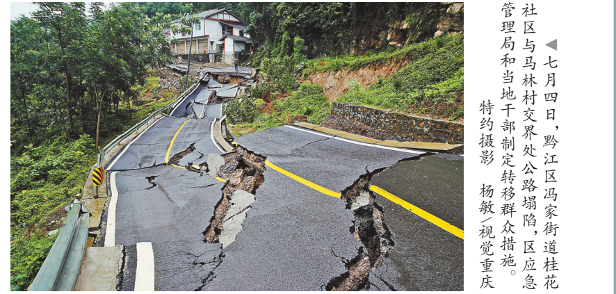
▲七月四日,黔江区冯家街道桂花社区与马林村交界处公路塌陷,区应急管理局和当地干部制定转移群众措施。特约摄影 杨敏 视觉重庆
