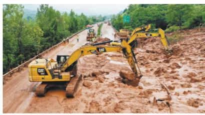
7月3日,抢险人员正在对綦万高速路二次滑坡,开展不间断除渣清淤作业。受连日强降雨影响,我市高速公路多地出现泥石流、滑坡、隧道渗水等险情,高速集团第一时间启动应急预案,抢险救灾。
