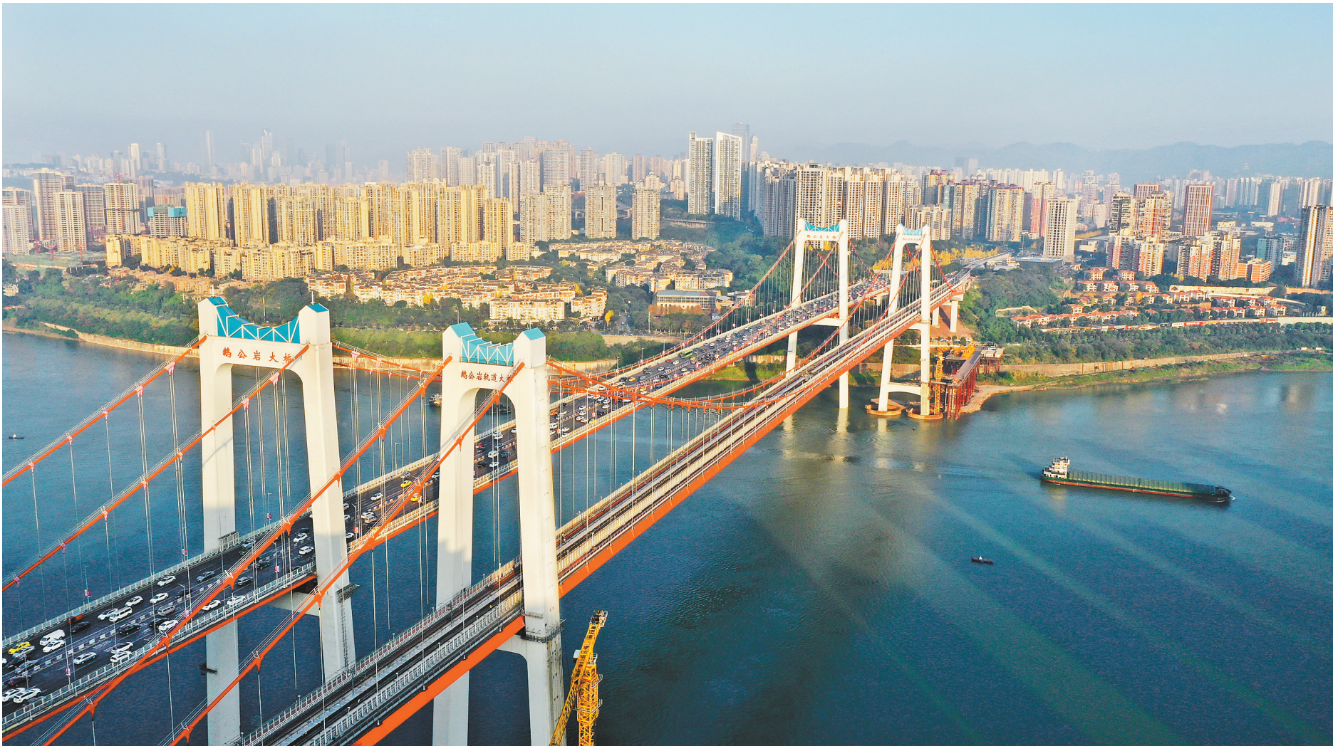
桥梁安全监测评价系统应用于世界上最大跨度自锚式轨道悬索桥——鹅公岩轨道专用桥。
