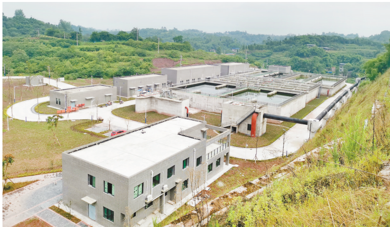
合川工业园区涪沱组团污水处理厂一期工程已投入试运行。 记者 陈维灯 摄 视觉重庆
