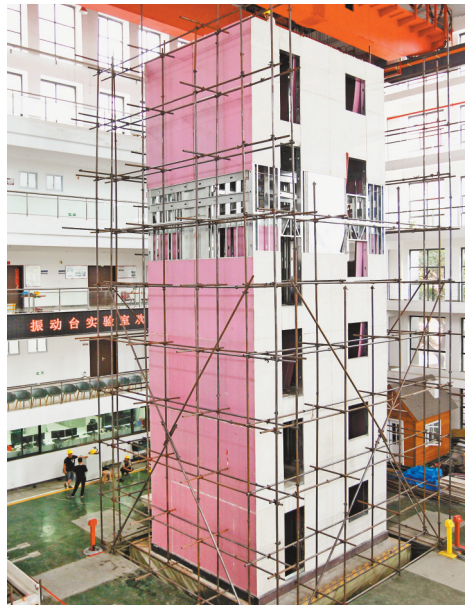
6月8日,重庆大学振动台实验室,工人师傅准备拆装6层实验房屋。该校建成可抗双向8级地震的6层钢结构“房屋”试验成功,为世界首次! 记者 卢越 摄/视觉重庆
