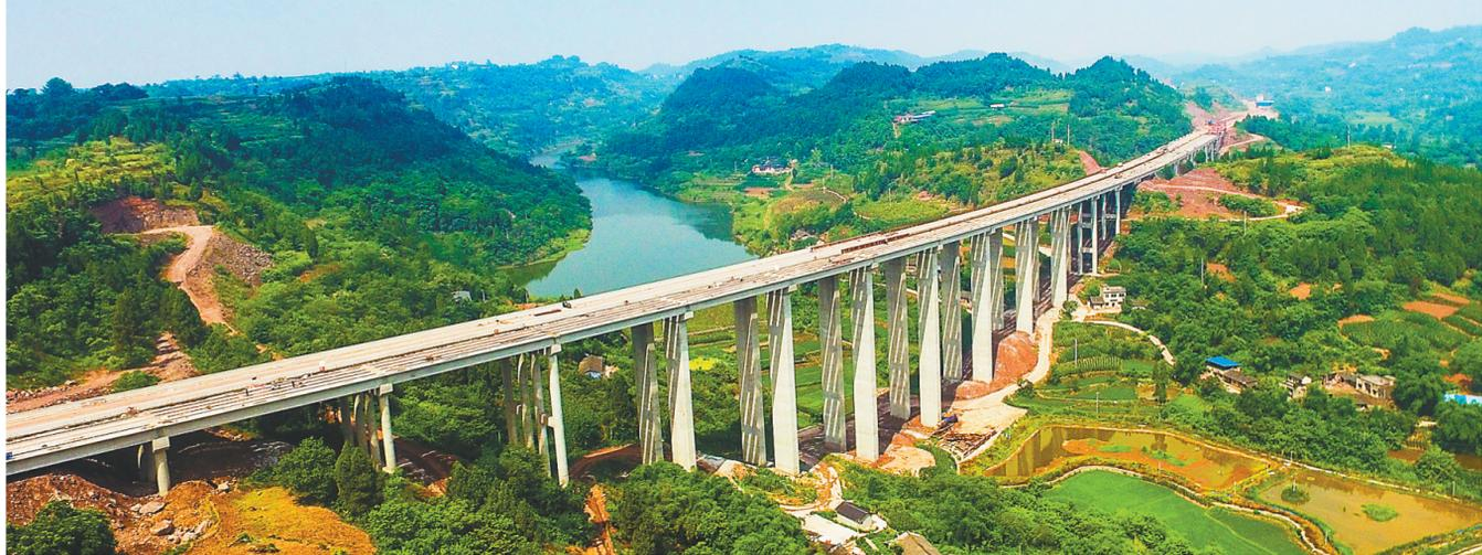
6月8日,随着架桥机将最后一块40米T梁精准落位,重庆合川至四川安岳高速公路重庆段控制性工程——石壁沟大桥提前全幅贯通,为合安高速年底
