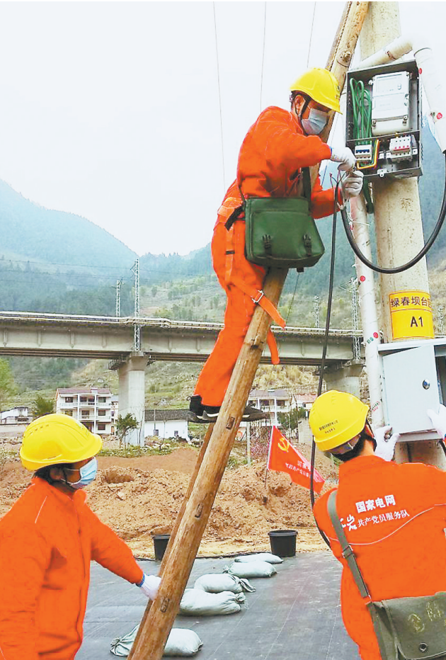
国网重庆丰都供电公司红岩共产党员服务队,在三建乡为绿春坝生态产业扶贫项目安装闸刀开关。(本报资料图片)
