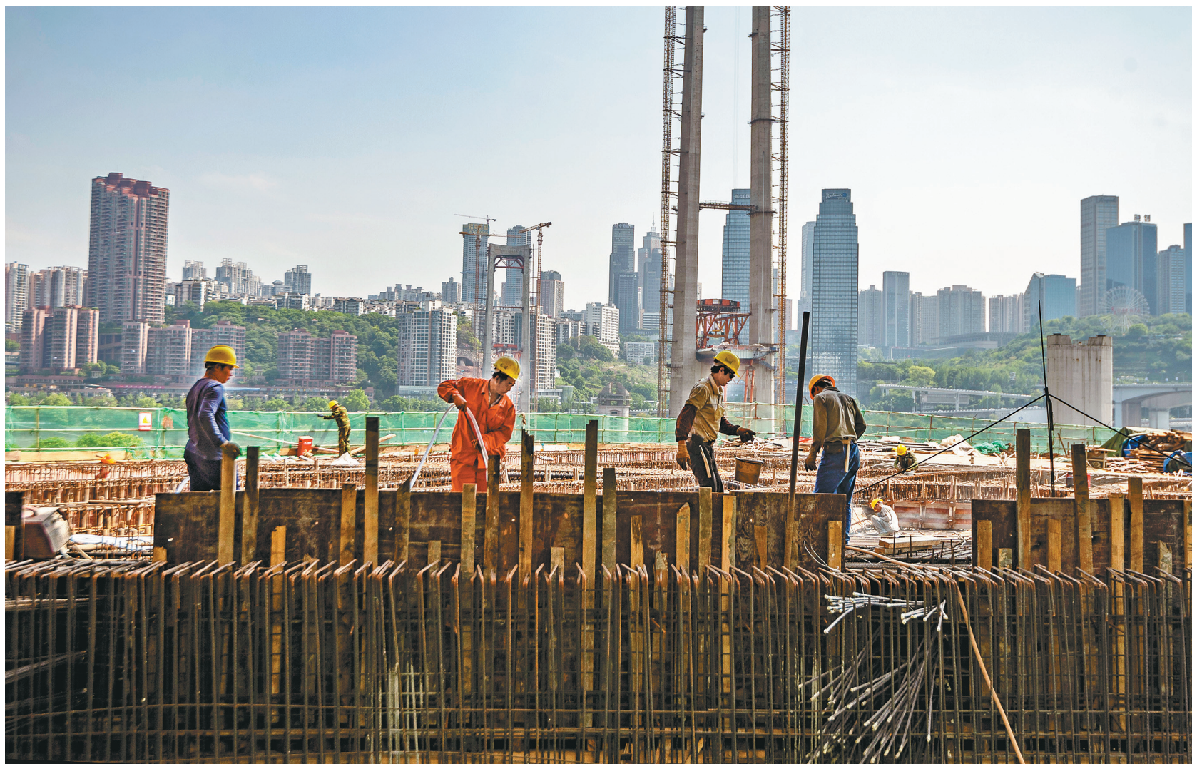
▲4月26日，渝中区长滨路，雷家坡立交建设工地，工人们正在加紧施工。随着疫情防控形势逐渐好转，该工程正有序推进。
