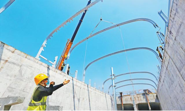
4月28日,6号线支线二期悦来至沙河坝工程现场,施工人员进行隔音墙吊装。
