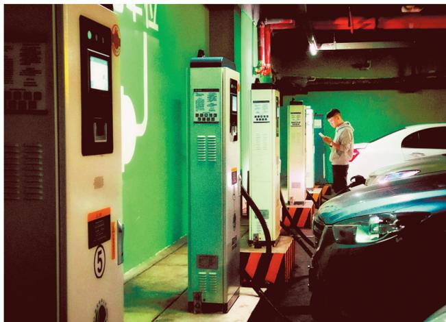
重庆市第一座商业地下直流充电重庆金科美邻汇城市充电站,配置120千瓦直流充电桩8台,7千瓦交流充电桩7台。(国网重庆市电力公司供图)
