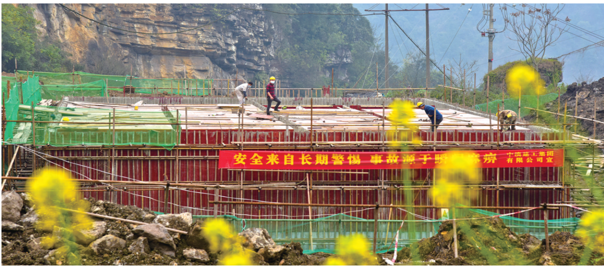
安山镇松桐片区供水改扩建工程施工现场 摄/黄波
