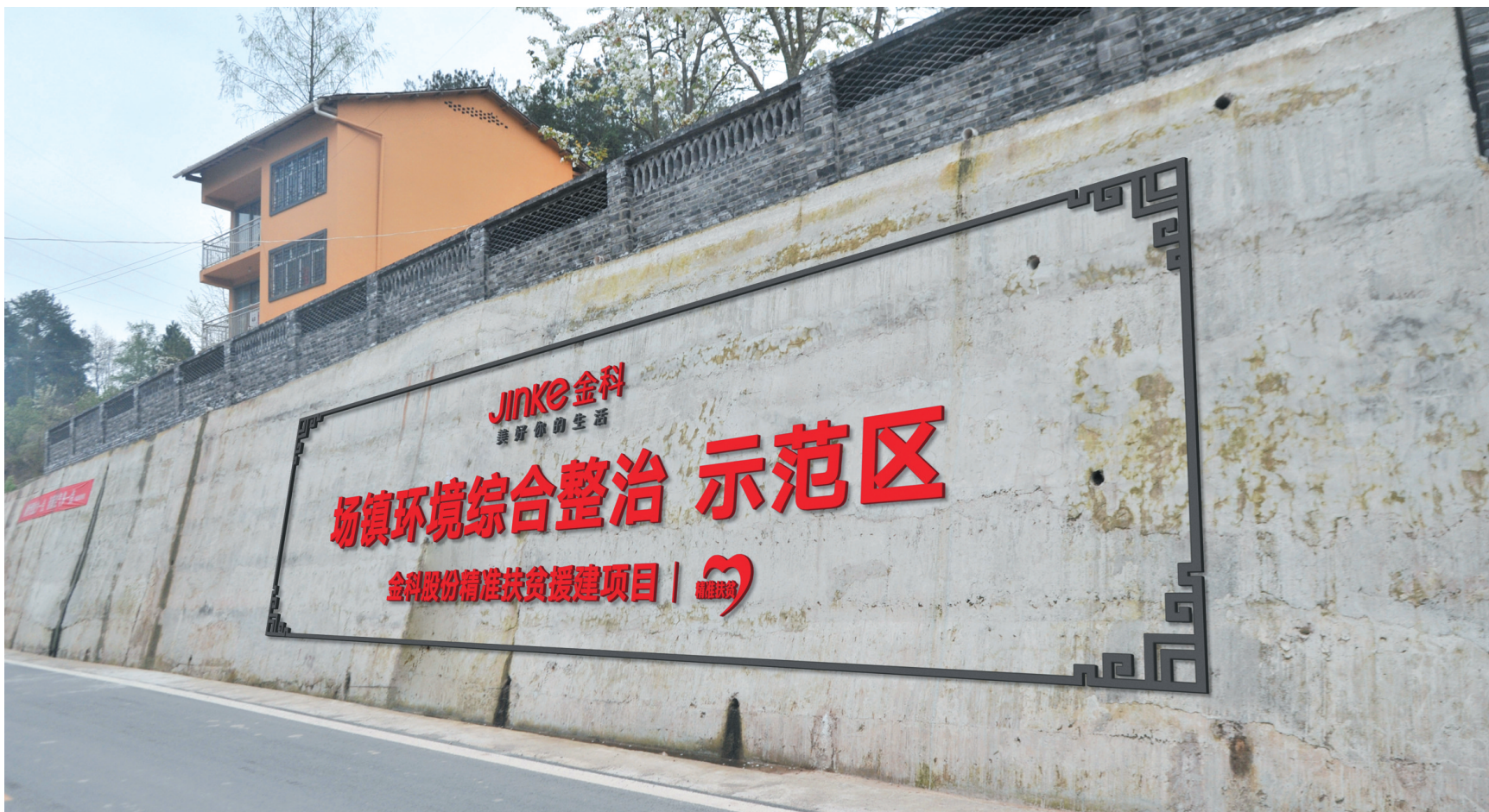
金科股份精准扶贫援建项目中益乡镇环境综合治理示范区
