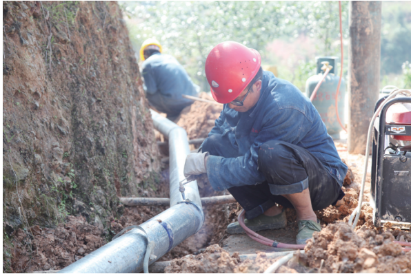
工人进行供水管网安装
