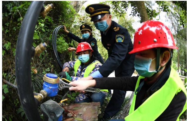
长滩镇沙滩村12组,扶贫驻村工作人员和水管安装工为脱贫户何德英家安装自来水设施 摄/何忠
